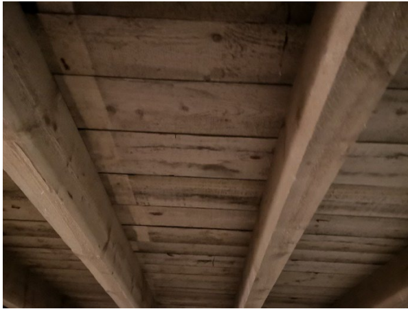
Bilder: Dachkonstruktion und Dachlatten im Neubau (keine Dämmung vorhanden)
