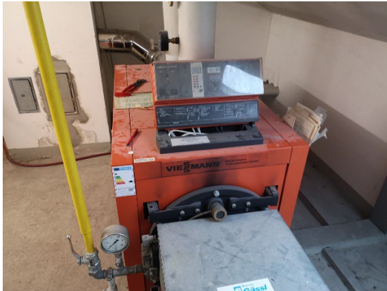
Bilder: Gasbrenner und 500 l Warmwasser-Boiler im Altbau
