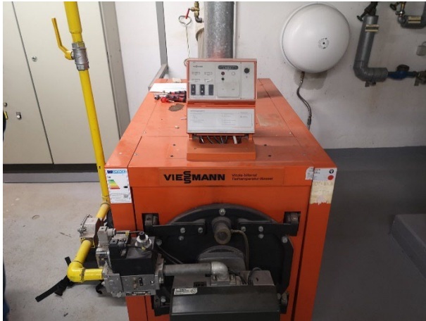
Bilder: Gasbrenner und 2 x 500 l Warmwasser-Boiler im Neubau
