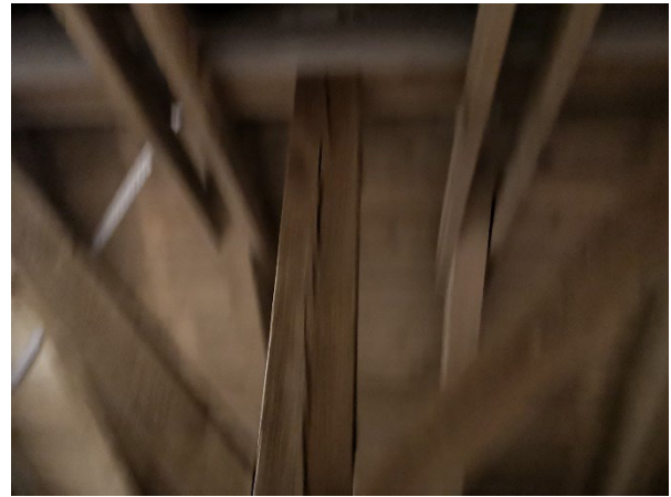
Bilder: Dachkonstruktion und Dachlatten im Neubau (keine Dämmung vorhanden)
