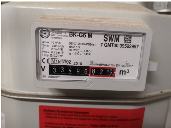
Bild: Gas-Zähler für die den Verbrauch des Vereins: 7 GMT00 09592957. Für die Gaststätte ist ein eigener Abzweig mit eigenem Zähler vorhanden.
